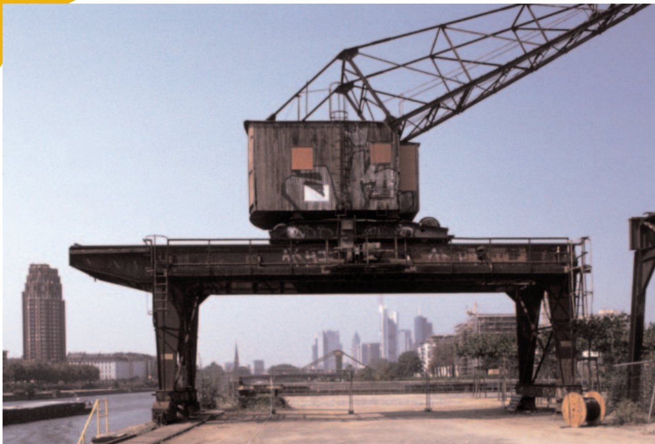
Elektrisch angetriebener Kran von 1911 auf verfahrbarem Portal im Osthafen
