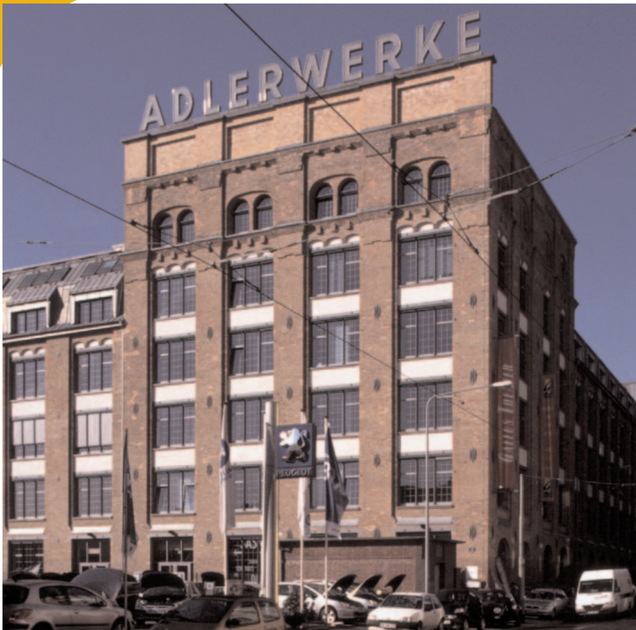
Stadtansicht der ehem. Adler Fahrradwerke vorm. H. Kleyer AG, erbaut 1912
