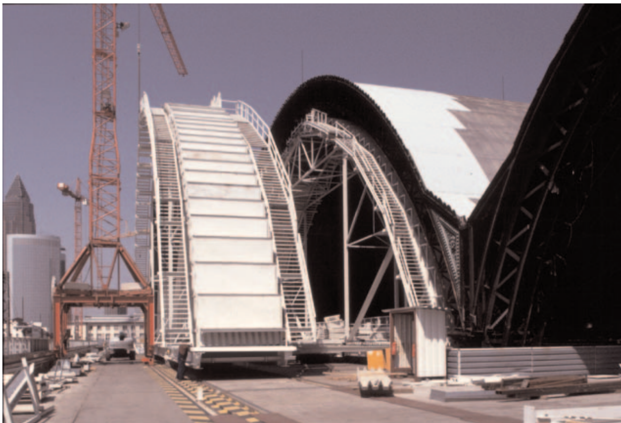
Sanierung Gleishallen Hauptbahnhof Frankfurt/Main, Arbeitsplattform mit Montagegerüst Foto: V. Rödel
