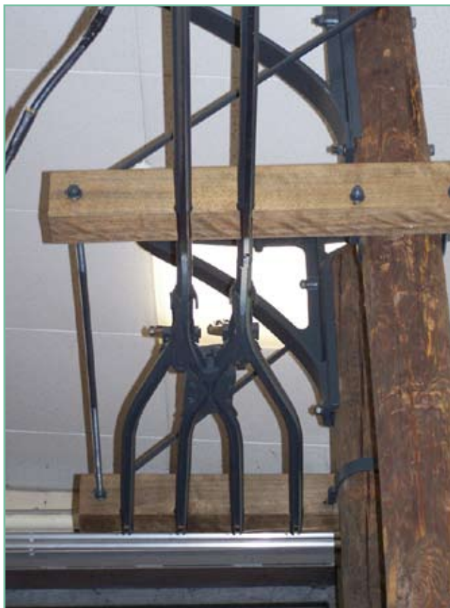
Weiche einer Schlitzrohrfahrleitung der FOTG im Verkehrsmuseum Frankfurt am Main
