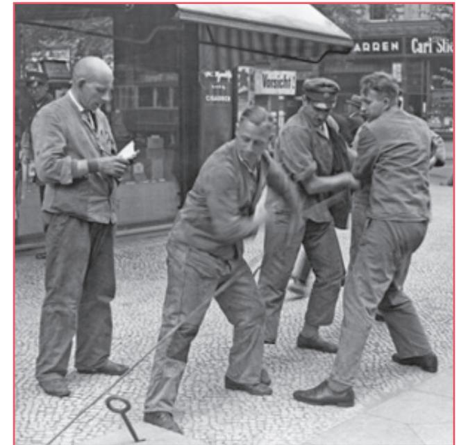
Bild 4: „Drahtzieher“. Das unterirdische Kabel wird an einem Seil befestigt und oberirdisch gezogen, 1930
