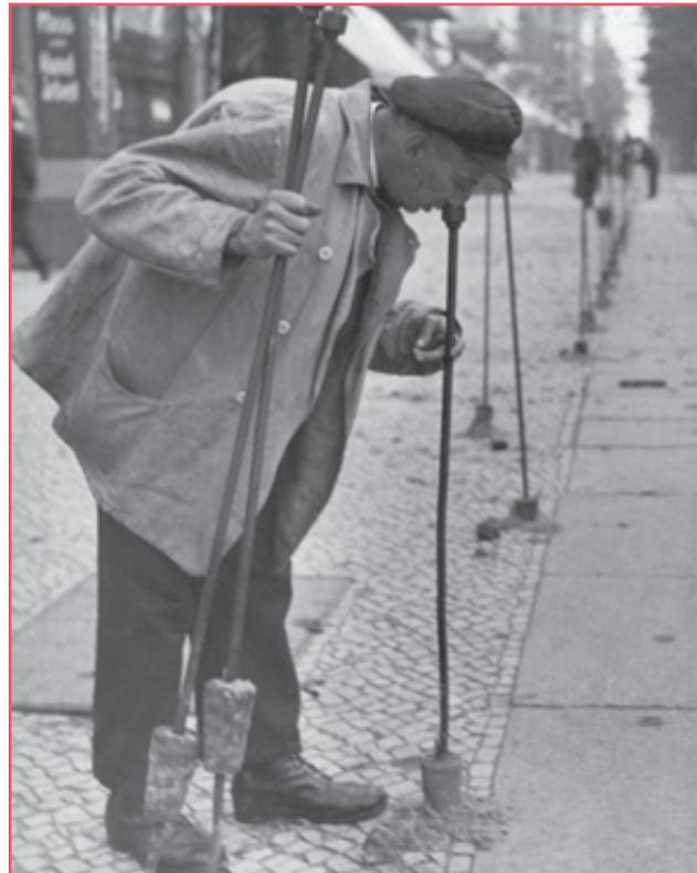
Bild 3: „Gasriecher“ beim Überprüfen der Gasrohre unter dem Fußwegpflaster, 1920er-Jahre.
